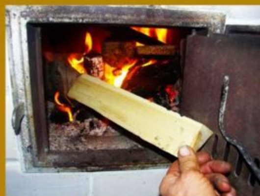
Размер дров должен соответствовать размерам топливника
